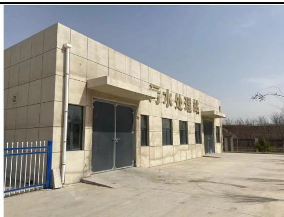
厂区污水处理站
