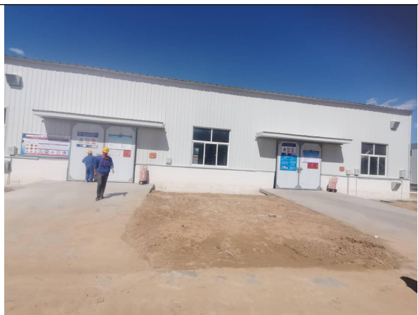
固废暂存间及危废暂存间
