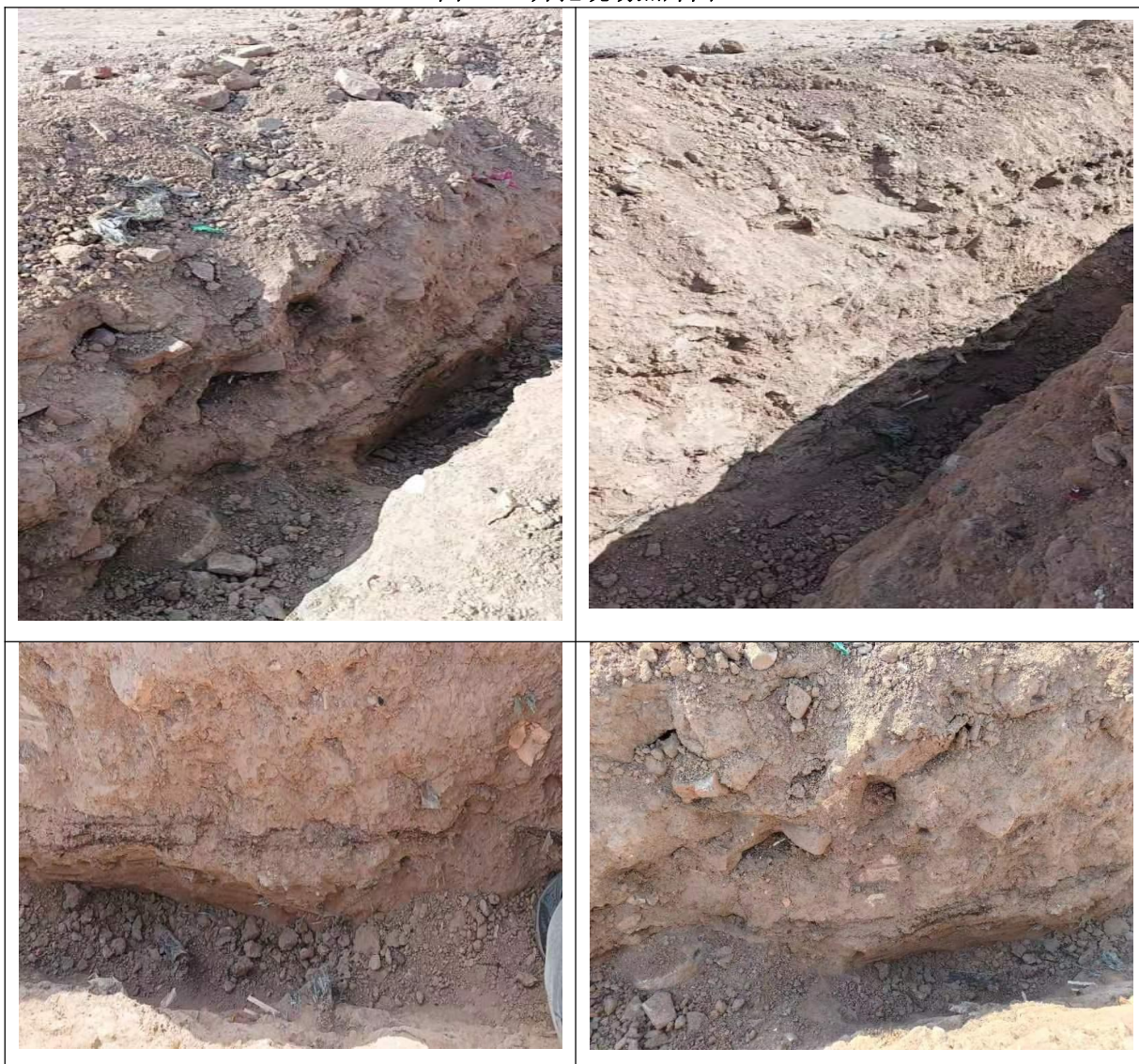
图 4-1 开挖现场照片图
