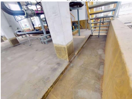
图 4-12 罐区围堰
