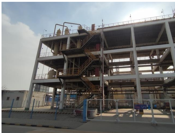
图 4-2 氯甲酸氯甲酯尾气处理系统
