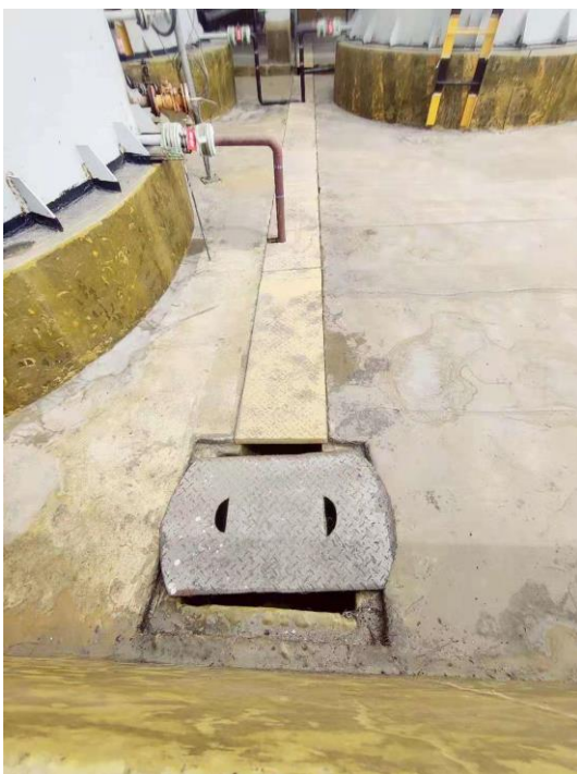
图 4-10 罐区导流槽
