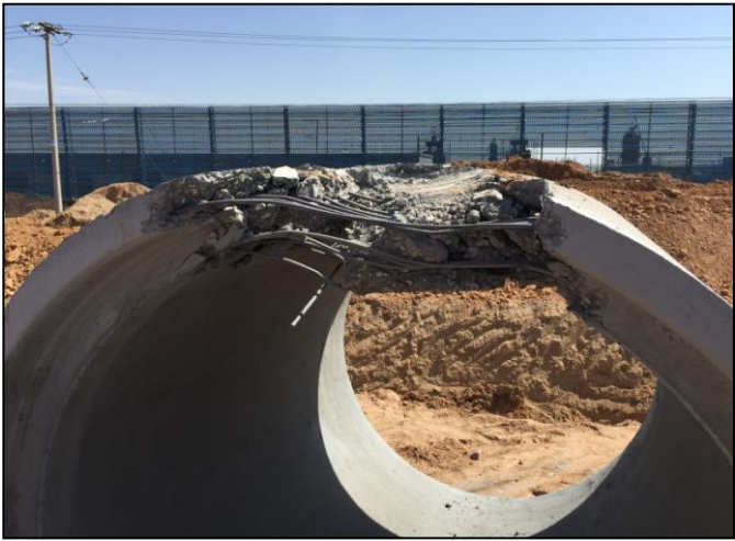
施工期围挡图片
