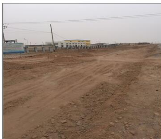
管线途径污水处理厂
