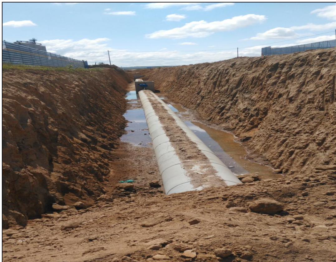
施工期围挡图片
