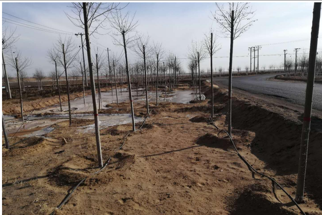
管道回填后的绿化
